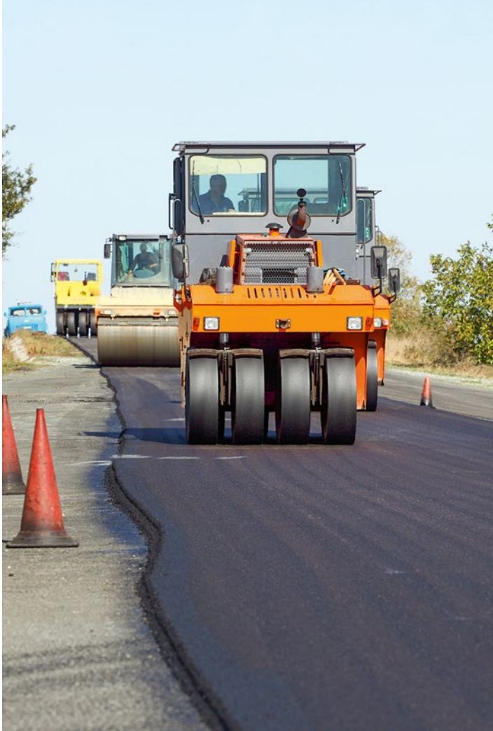
Straßenbaufirmen mögen den Asphaltmix mit Vestenamer, weil er gut zu verarbeiten ist und die Maschinen trotz des Gummianteils nicht verschmutzen.
