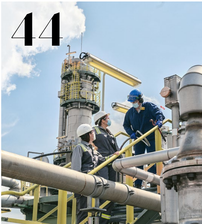
Der neue MACBETH-Reaktor könnte große Aufreinigungsanlagen wie diese in Marl überflüssig machen.
