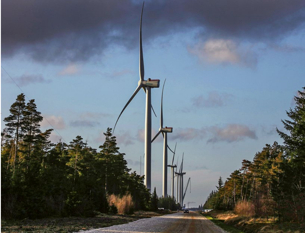
Giganten im Test: Im dänischen Østerild werden an Land die Offshore- Windanlagen verschiedener Hersteller mehrfährigen Prüfungen unterzogen.
