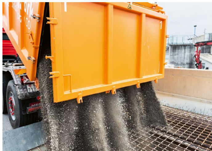
Recycelt oder frisch? Für die CO 2 -Bilanz von Beton macht die Herkunft der Inhaltsstoffe einen großen Unterschied.
