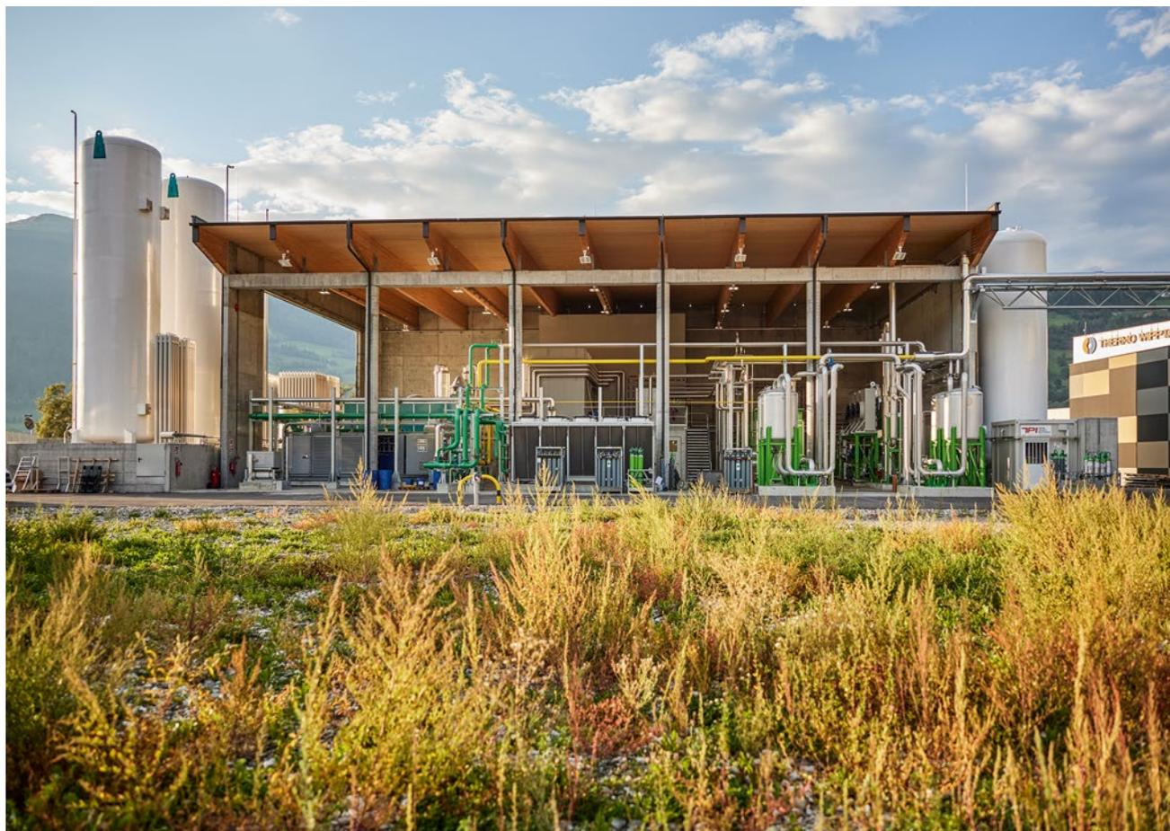
wiegend aus Mais, aber auch aus Ganzpflanzensilage, Getreide und Grassilage bestand, Biomethan hergestellt und in das 25-Bar-Erdgasnetz eingespeist. Mehr produziert keine Anlage in Deutschland. Konstrukteur EnviTec Biogas hat sie im April 2021 selbst übernommen und umkonzipiert.
