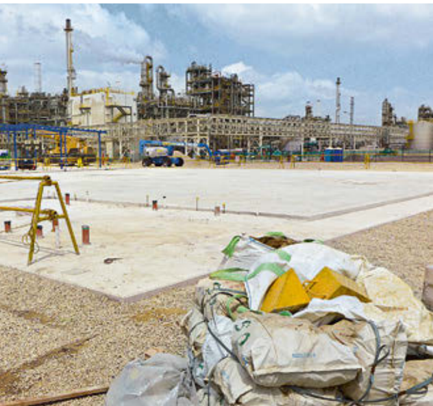
Die Arbeiten für die Erweiterung der Methioninanlage laufen bereits. Im kommenden Winter sollen die neuen Komponenten in den bestehenden Prozess integriert werden.
