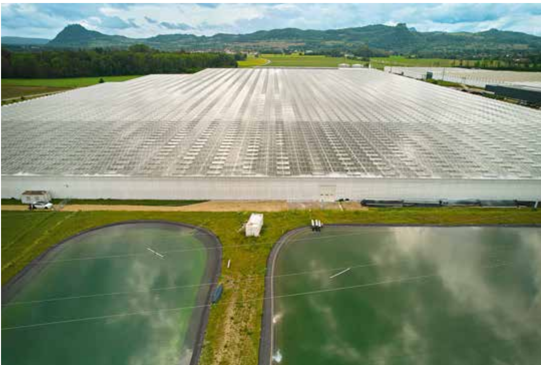
Sicher versorgt: Der Gemüsebetrieb von Tobias Jörg in Singen sammelt das Regenwasser vom Glasdach und speichert es in Teichen mit insgesamt 36 Millionen Liter Fassungsvermögen.
