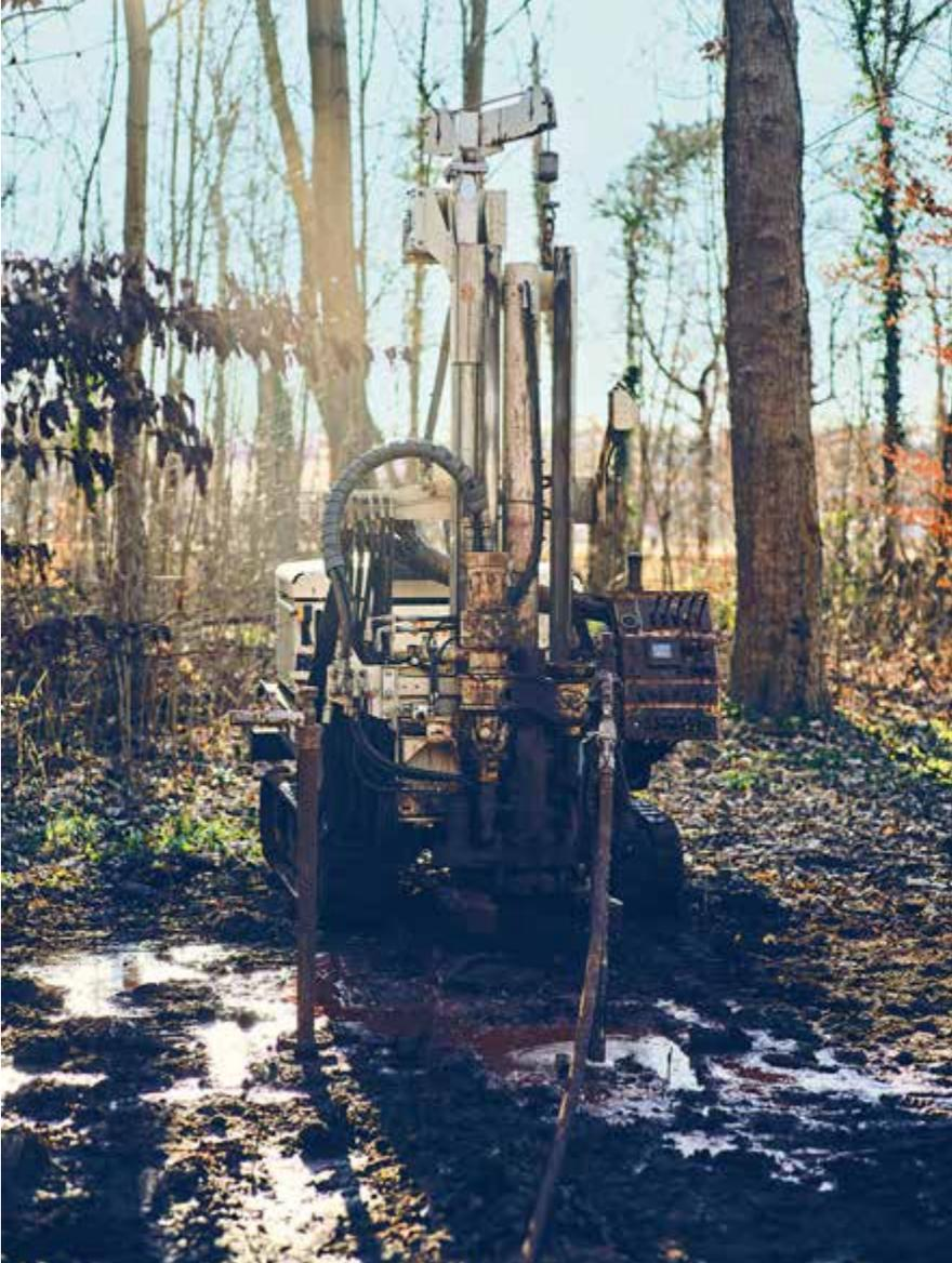
Spezielle Bohrmaschinen treiben Metallrohre in die Erde, durch die Reagenzien ins Erdreich gepumpt werden.
